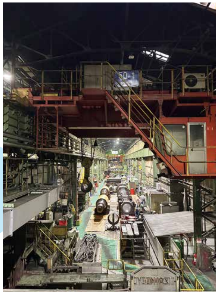
天井クレーンを利用してケーブルを敷設
